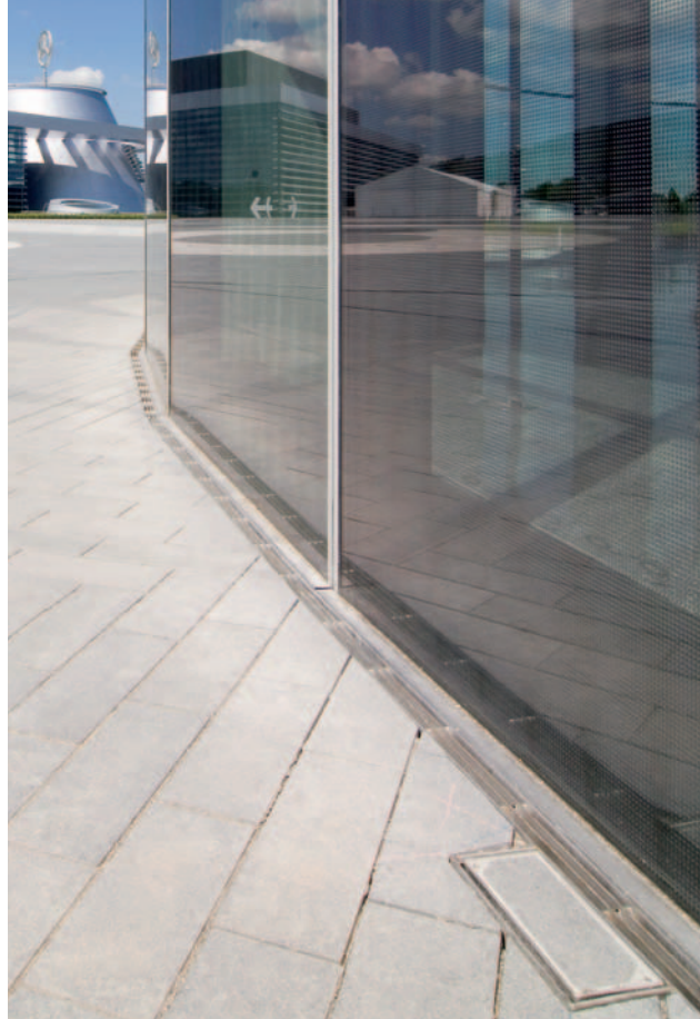
Voda stékající z fasád je sbírána do žlabů s podélnou štěrbinou a odnímatelnými bočními stěnami. Unikátní revizní kusy umožňují přístup do žlabů pro potřeby údržby.
