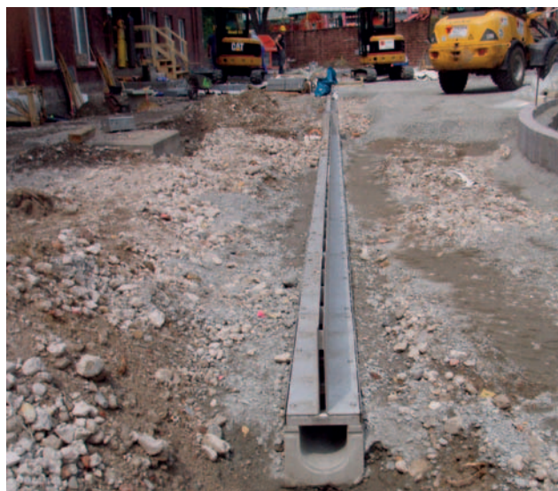
Pokládka pevných štěrbinových žlabů s kryty z nerezové oceli tloušťky 4 mm a výškou hrdla 280 mm.
