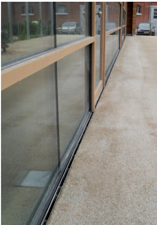
Asymetrický štěrbinový žlab pro odvodnění fasády
