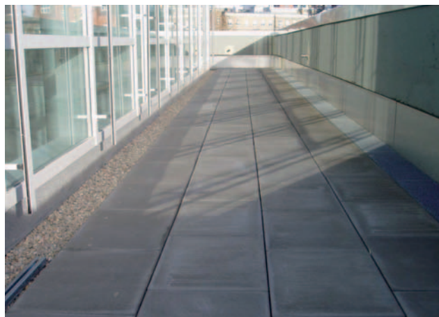
Pro odvodnění terasy na střeše byly navrženy specifické žlaby DACHFIX.
