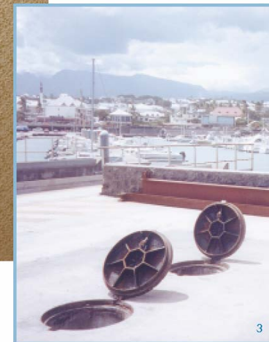
Obrázky : PolyGD v lodním doku 1. část odlučovače s kalovou jímkou 2. odlučovací část odlučovače 3. instalovaný odlučovač s otevřenými přístupovými poklopy
