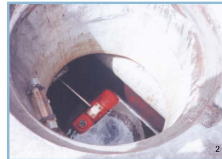
Obrázky : PolyGD v lodním doku 1. část odlučovače s kalovou jímkou 2. odlučovací část odlučovače 3. instalovaný odlučovač s otevřenými přístupovými poklopy
