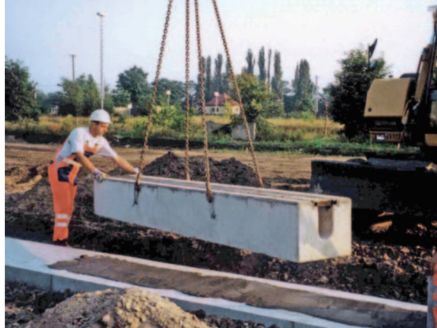
Dlouhé elementy znamenají rychlou a efektivní montáž
